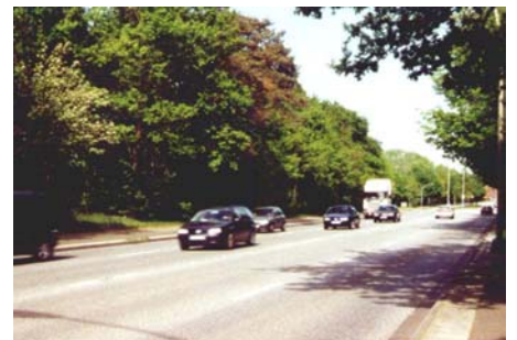
Bundesstraße 73 als Lärmquelle
