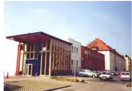
Abb. 127: Kindergarten in total umgebautem Kasernengebäude. Boehn-Kaserne.
