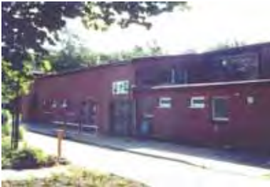
Abb. 85: Zivil weitergenutzte Turn- und Sporthalle auf der Scharnhorst-Höhe, Hamburg-Heimfeld.
