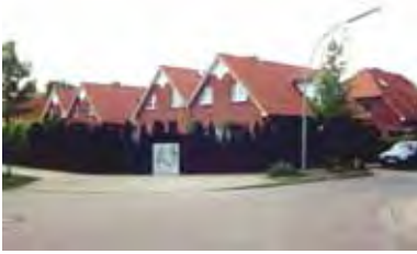
Abb. 30: Verdichtete Einzelhäuser in Neuwiedenthal-Nord.
