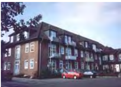
Abb. 120: Umbau in öffentlich geförderte Wohnungen. Estetal-Kaserne.
