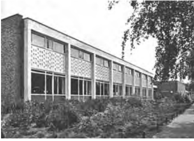
Abb. 90: Wirtschaftsgebäude an der westlichen Haupteinschließung. Quelle: AIV (1969).
