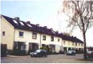
Abb. 24: Reihenhäuser in Neu-Fischbek.
