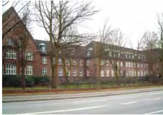
Abb. 87: Ensemble von Kasernenbauten aus den 30er Jahren an der B 73.
