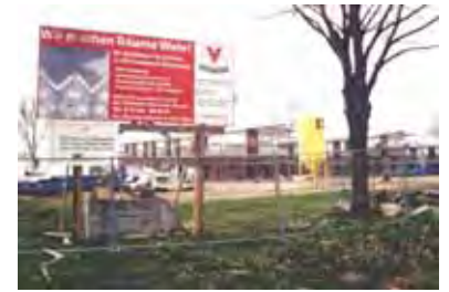
Abb. 34: Baustelle Ohrnsweg, Sandbek.
