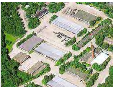
Abb. 91: Ausschnitt aus dem technischen Bereich mit Heizkraftwerk. Quelle: Hamburger Abendblatt (2002).
