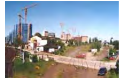
Abb. 51: Ehemaliger Güterbahnhof und Baukräne im Channel Harburg.
