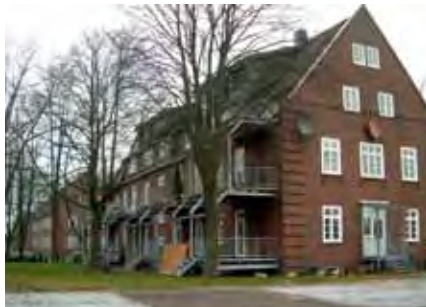
Abb. 124: Kleine Wohnungen mit vorgesetzten Balkonen. Stade-Ottenbeck.
