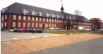
Abb. 116: Preiswerte Büroräume im Torgebäude der ehemaligen Estetal-Kaserne.
