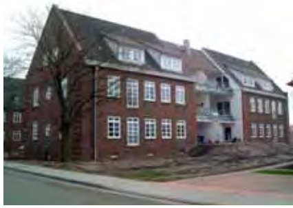
Abb. 122: Große Eigentumswohnungen mit Loggien. Ehemalige Von-Goeben-Kaserne, Stade-Ottenbeck.
