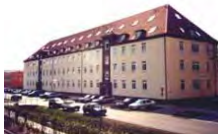
Abb. 117: Umbau zu einer Unterkunft für Asylbewerber, inzwischen als Internat genutzt. Boehn-Kaserne, Hamburg-Rahlstedt.
